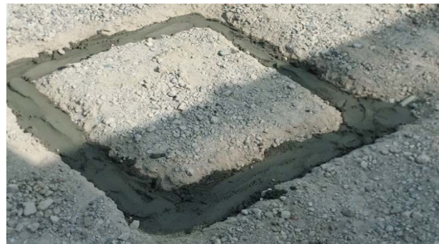
【モルタル注入後】
