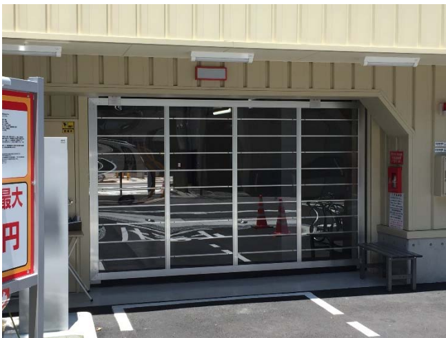
入庫口正面...車庫の扉がスケルトンになっています
